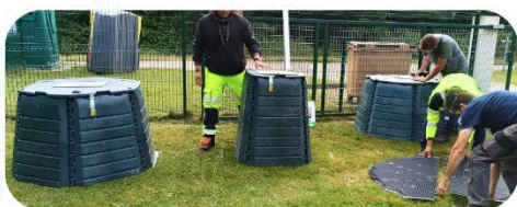
Installation du composteur partagé du centre de loisirs Casteljaloux, Juin 2023
